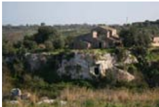
TA205 - La masseria Molinello e, alla base, il sito
