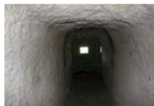
TE1512 - L'interno del bunker
