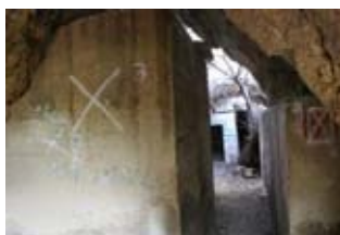
TE1511 - L'interno del Cozzo Telegrafo, con le strutture riconducibili al bunker
