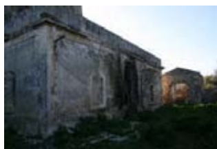
TE616 - Le strutture abbandonate del Faro
