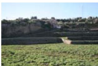
TE618 - Campi coltivati, terrazzamenti di nuova sistemazione e casa abbandonata sul lato Sud della Cava
