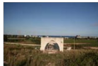
MA1406 - Ancora la struttura di protezione del sito e la costa sullo sfondo
