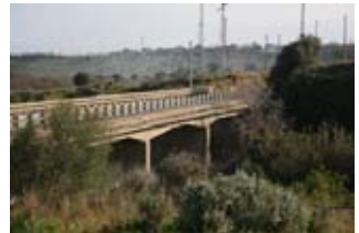
TA211 - Il ponte sul Molinello della strada da cui si accede al sito: visibili la masseria e il Petrolchimico
