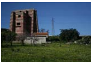
TE617 - Un'altra veduta del Faro con alle spalle la SS114
