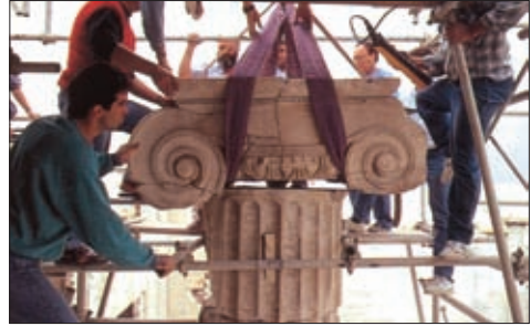
Fig. 5 - Propilei. Anastilosi di un capitello ionico durante i restauri del 1992
