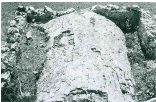
Fig. 6 - Dammuso di Gallo: il teatro a «botte» rivestito con piastrelle di terracotta.
